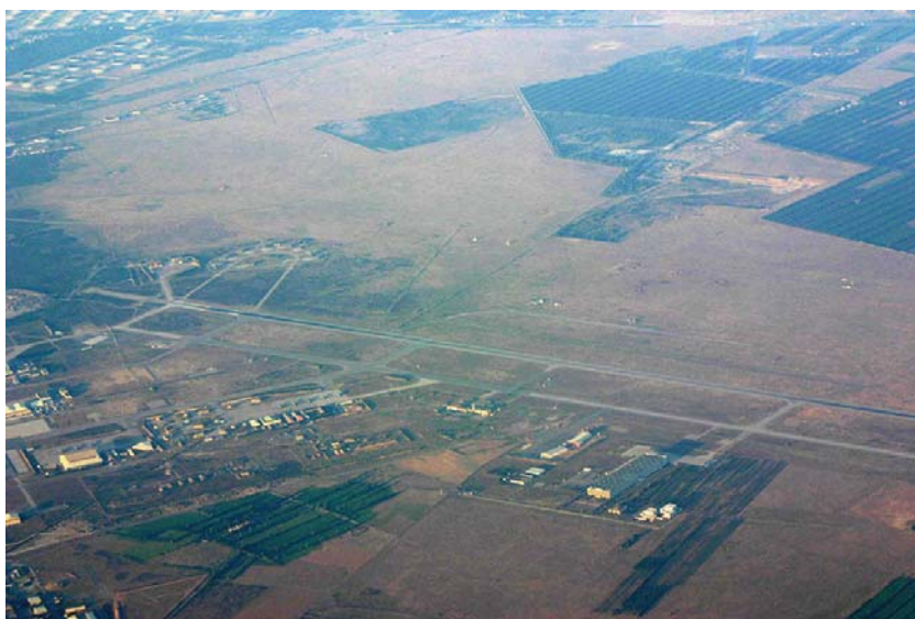
Vue aérienne d'une partie de la piste de la base 125
